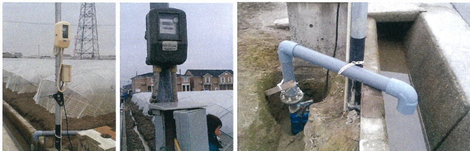
排水対策事例：圃場内に電柱を立て、水中ポンプを常備しています。！
