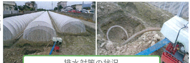
排水対策の状況
